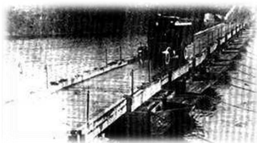
Собранный мост из полупонтонов ДМП
